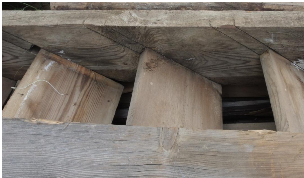
Figuur 21 Liggende trap, waarbij duidelijk de scheve insteek van de planktreden zichtbaar is. In dit geval zijn ze ingezet in een gleuf, maar liggend op een inkeping is ook mogelijk., openluchtmuseum Vilnius (© BIAX).
