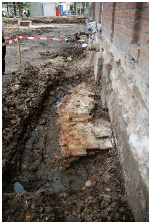
Figuur 1 Fundamenten van een vestingsmuur, waarschijnlijk van het 16 e eeuwse bastion, onder de muur van het huidige sportcentrum bij het KMA-terrein in Breda. Foto: © Bureau Cultureel Erfgoed, Gemeente Breda.
