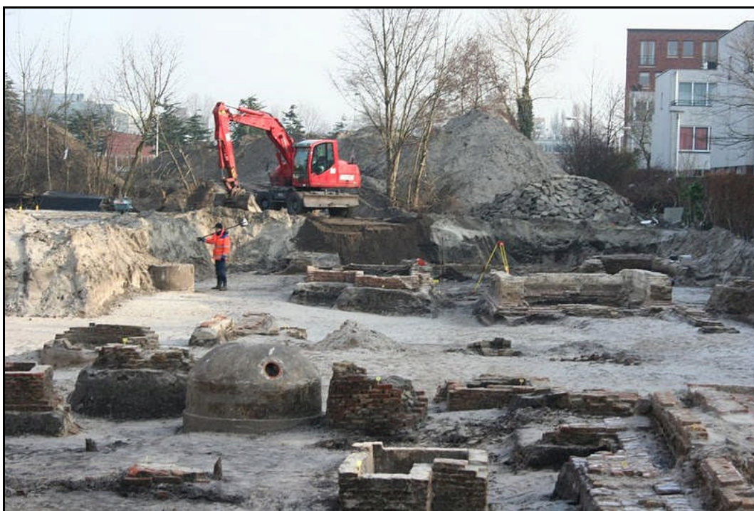
Figuur 2 Overzichtfoto van de opgravingswerkzaamheden met funderingen van boerderij Groenesteijn. De 'glasbak' was waarschijnlijk onderdeel van de waterafvoer van het laat 19 e -eeuwse weeshuis (© Dienst Stadsbeheer).
